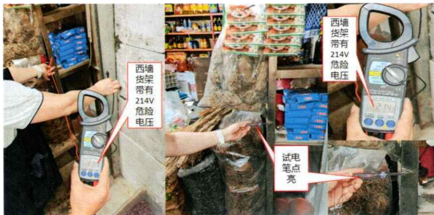
图十六 商铺内用电设备勘查图
