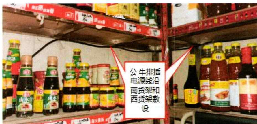
图二十一 公牛排插电源线敷设情况勘查图 拍摄单位：公明街道办事处 拍摄时间：2023年7月29日
