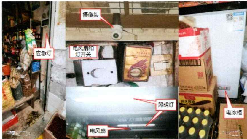
图十五 商铺内用电设备勘查图
