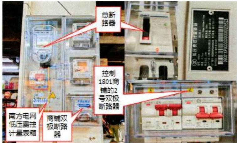
图二十六 南方电网低压费控计量表箱勘查图 拍摄单位：公明街道办事处 拍摄时间：2023 年 7 月 29 日
