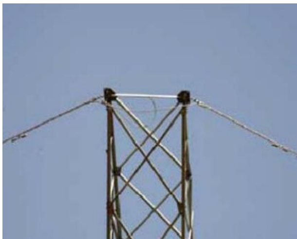
OPGW 耐张金具串安装（直通型）
