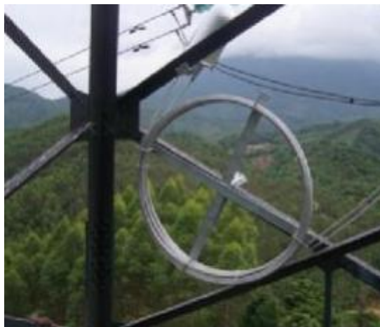
铁塔 OPGW 接头盒及余缆架安装
