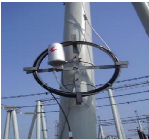
构架 OPGW 接头盒及余缆架安装
