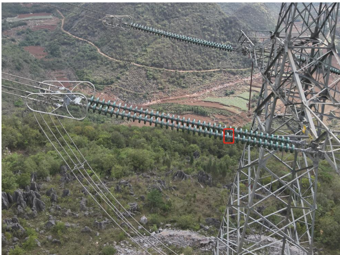
图 3、±500kV 直流玻璃绝缘子图
